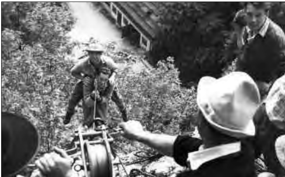
Bereits 1957 wurden Erfahrungswerte mit neu entwickelten Geräten – wie hier mit einer Stahlseilwinde – gesammelt.
